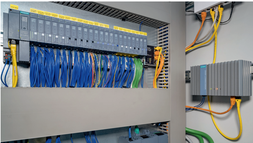
Bild 4. Schaltschrank: Der kompakte Open Controller (links) integriert die Funktionen eines PC-basierten, fehlersicheren Software-Controllers. Sicheren Datentransfer zwischen Maschine und dem Softwaresystem MindSphere realisiert rechts im Bild ein MindConnect Nano-Device © Siemens
